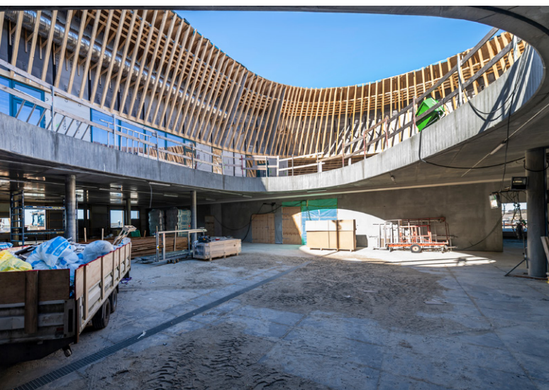
Maritimt Center på Esbjerg Strand under opførelse.
